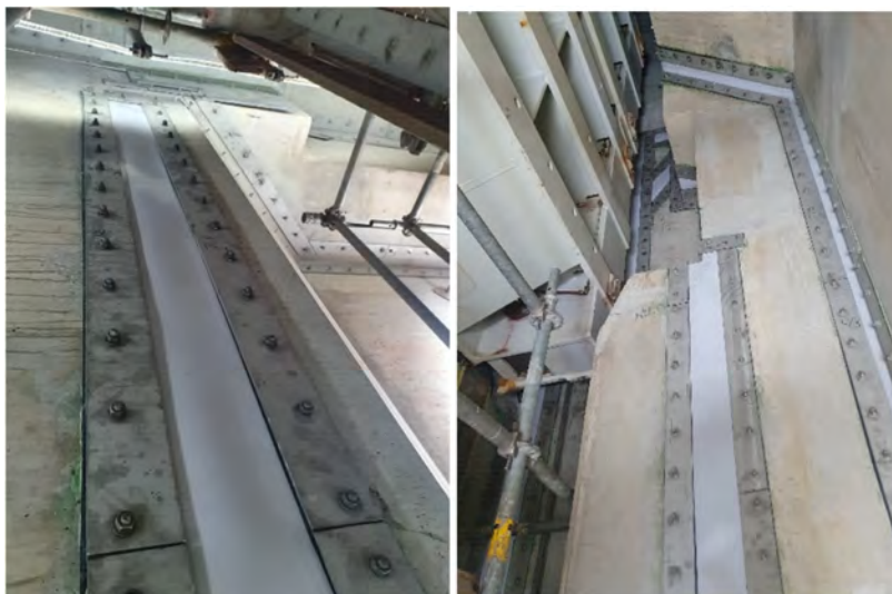
Fig. 13 Repair of cracked areas Réparation des zones fissurées
