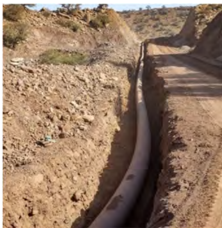
Fig. 6 PEHD Discharge Pipe during installation Pose de la conduite de refoulement en PEHD
