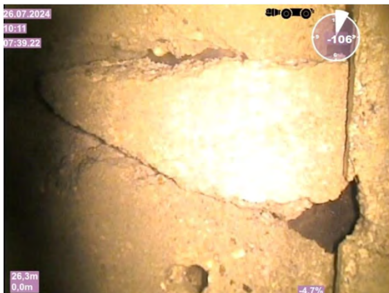
Fig. 7 Broken drainage pipe tuyau de drainage cassé
