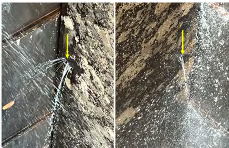
Fig. 4 Leaks in secondary concrete of upstream stoplog (upstream stoplog installed) Fuites dans le béton secondaire du sabot d'arrêt en amont (sabot d'arrêt en amont installé)
