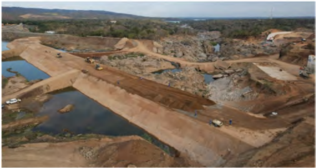
Fig. 2 Overview of Cemented Soil Placement at Kapichira dam in Malawi Aperçu de la mise en place du sol cimenté
