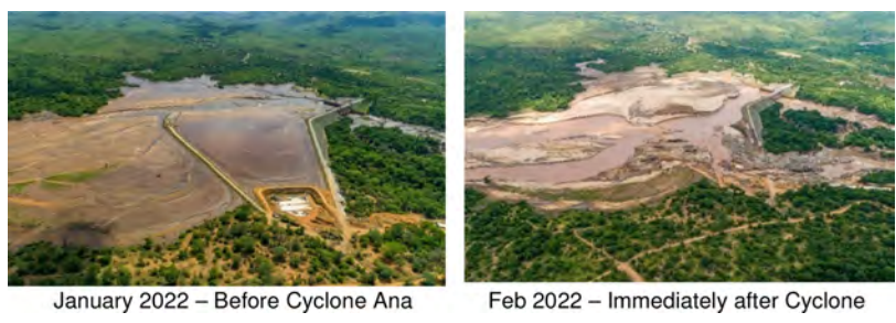
Fig. 1 Overview of Kapichira Dam and Cyclone Damage Aperçu du Barrage de Kapichira et des dégâts causés par le cyclone
