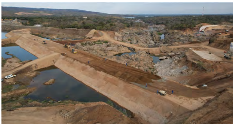
Fig. 13 Overview of Cemented Soil Placement Aperçu de la mise en place du sol cimenté
