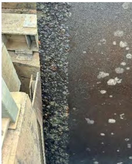
Fig. 3 Pitting corrosion on the edge of the skinplate Corrosion par piqûres sur le bord de la tôle d'acier
