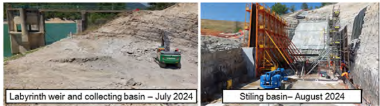
Fig. 15 Excavation and concrete works Travaux de terrassement et bétonnage
