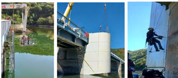
Fig. 31 a), b), c) Pier nose construction Construction des nez de piles
