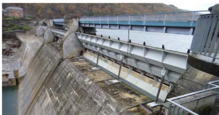
Fig. 21 Pinet dam – bottom-hinged flap gates and new road bridge Barrage de Pinet – Faces aval des clapets fermés et nouveau pont-route
