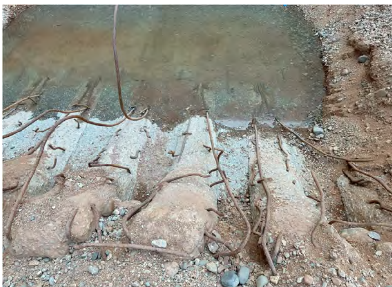
Fig. 3 Damage to Existing Slotted Roller Bucket Dommages au godet à rouleaux à fentes existant
