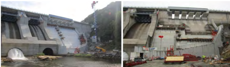
Fig. 6 a) Protection slab, b) flip bucket a) protection du parement, b) Cuillère de dissipation
