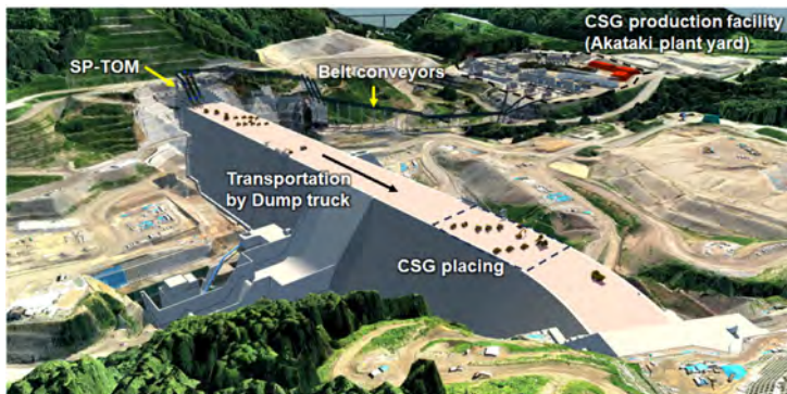
Fig. 7 Construction of CSG concrete Construction en béton CSG
